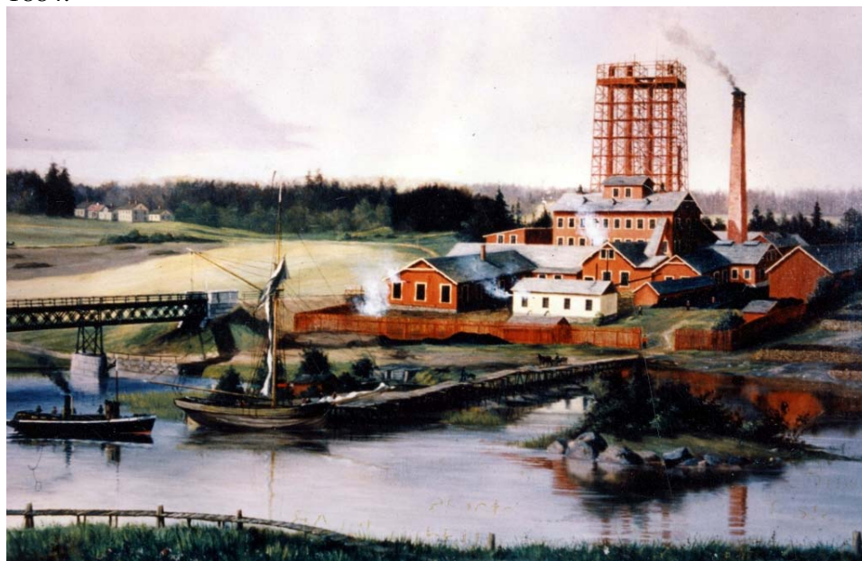
Billeruds Bruk omkring 1890. De i texten omnämnda syratornen har byggts, pumphuset (det vita huset i förgrunden) har byggts till med ett fönster och en andra intagsledning och en transportör från flishuggningen till kokeriet har tillkommit.
